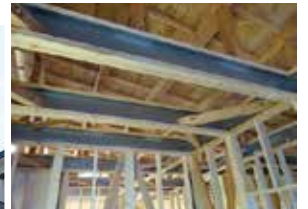
▲実際の構造写真 木と鉄の複合梁(テクノビーム)の様子
